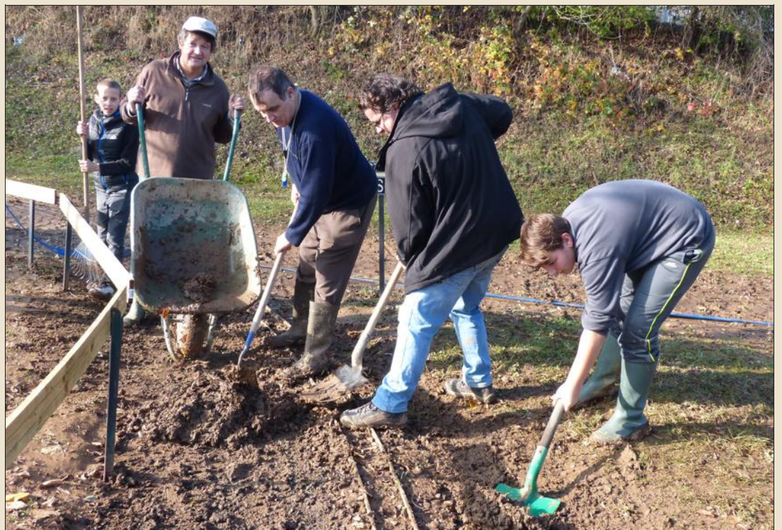
■ Des brouettes entières de boue ont dû être chargées, afin de dégager le ballast. Photo Monique ALLIX-COURBOY
